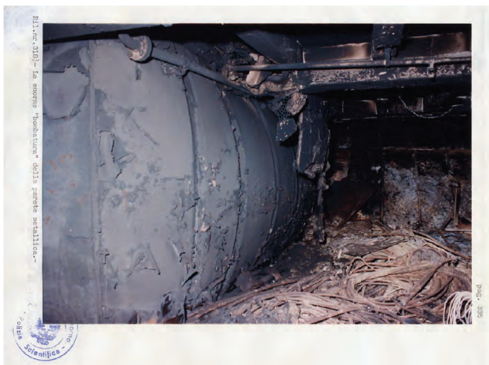
Figura 11. Deflessione della paratia poppiera del locale motore elica di manovra, vista dall'esterno.
