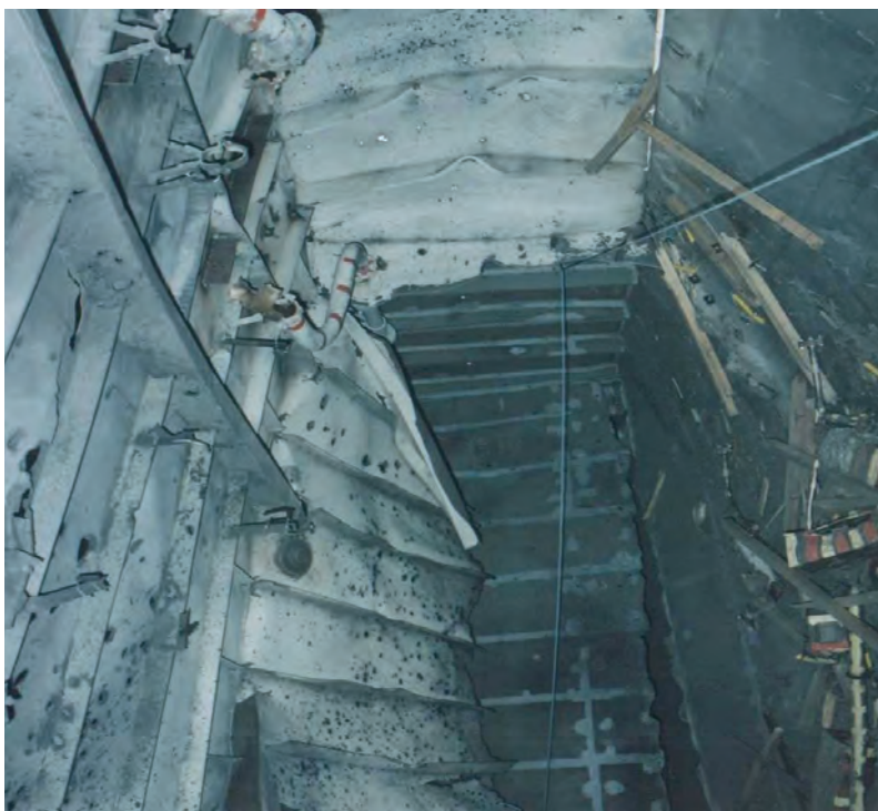
Figura 3. Effetti della detonazione di una carica di esplosivo ad alto potenziale nel locale di una nave.
