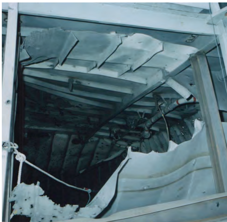
Figura 4. Strappi e perforazioni delle lamiere dovuti all'esplosione di esplosivo ad alto potenziale nel compartimento di una nave.
