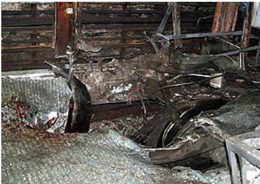
Figura 7. Danni ad una carrozza della metropolitana di Londra prodotti da un ordigno esplosivo improvvisato (IED).
