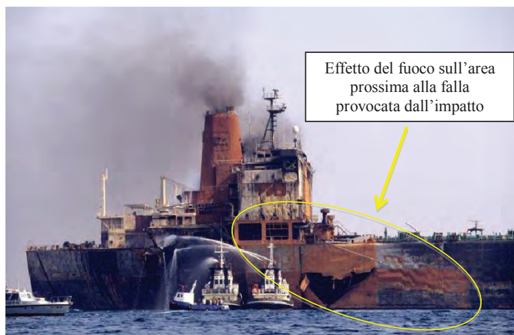
Immagine 35 - Agip Abruzzo: segni dell'incendio
